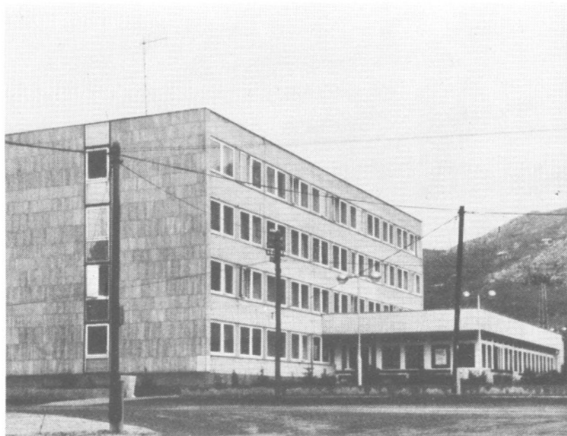
Felépült a nagyközségi tanács és az MSZMP impozáns épülete
