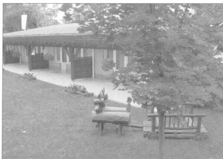
A Kamaraerdei Óvoda
